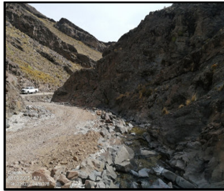
SE OBSERVA ROCAS DE GRAN TAMAÑO INESTABLEMENTE POSICIONADA EN LA MARGEN IZQUIERDA DE LA QUEBRADA PALCA
